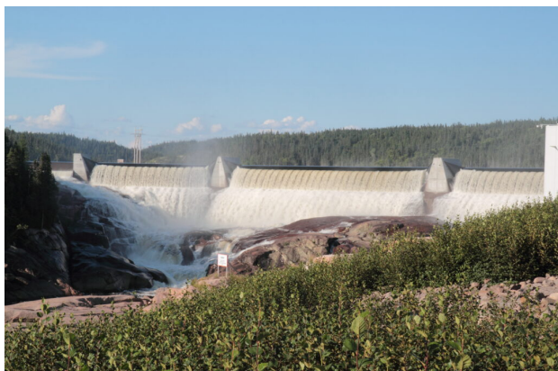
Barrage sur la rivière Magpie (Canada) ( source )
