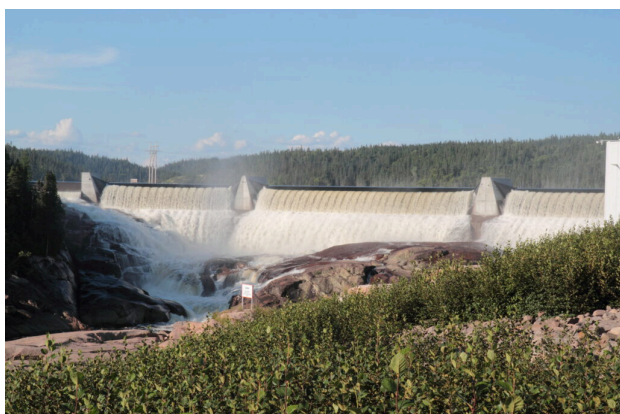
Barrage sur la rivière Magpie (Canada) ( source )
