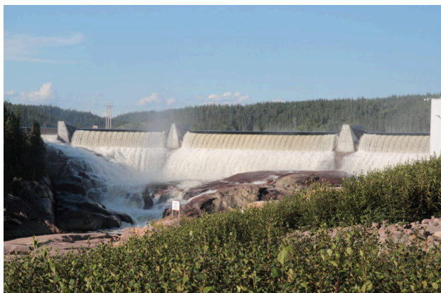
Barrage sur la rivière Magpie (Canada) ( source )
